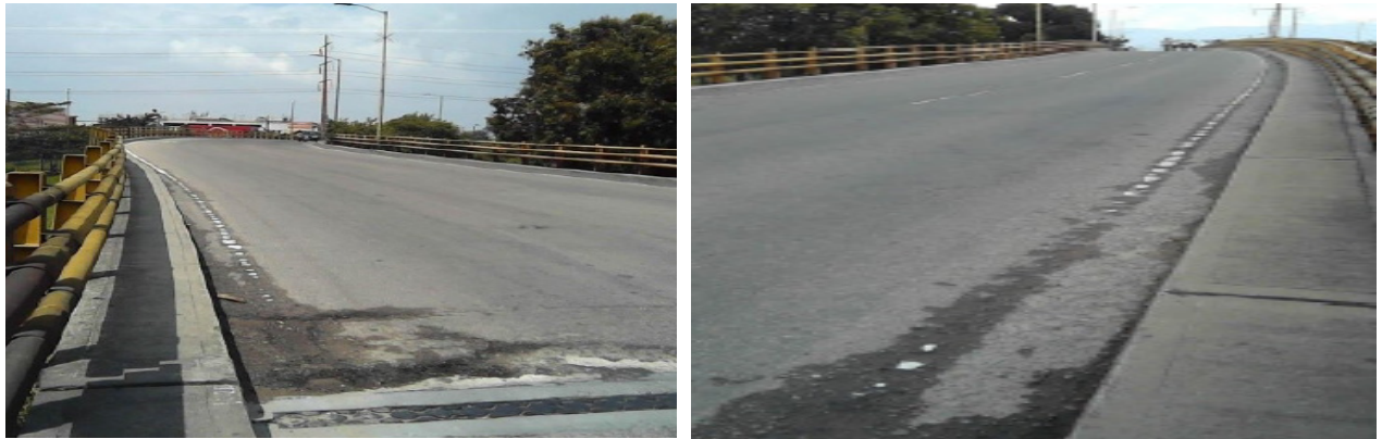
Fig. 3. (a) y (b). Parte superior del puente vehicular sobre la Avenida Jorge Gaitán Cortés con Avenida Quiroga, saliendo por la calle 36 sur.
