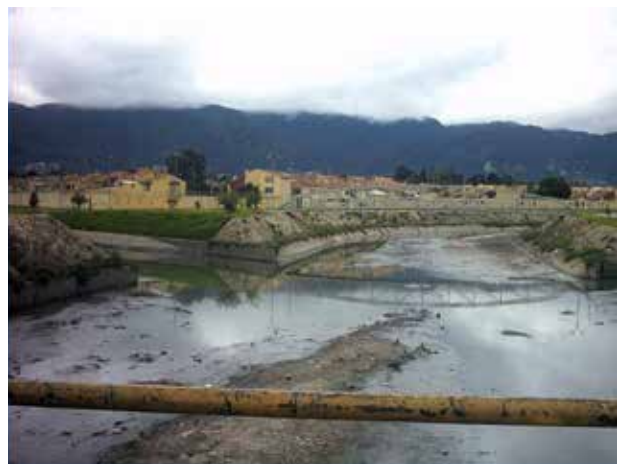
El Río Salitre canalizado ¿Esta es la preferencia de muchos ingenieros y urbanistas? Obra del trazo, la escuadra y el mortero ¿Es esto realmente un río? Foto: William Antonio Lozano-Rivas
