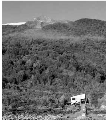
Figura 17. Una de las primeras obras de travesías a la Patagonia occidental, realizada en 1988 en San Ignacio de Huinay. Archivo historico José Vial Armstrong PUCV.
