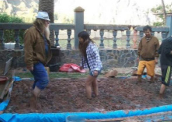
Imagen 2 Construcción de un horno de alta eficiencia (Moretti, 2017).
