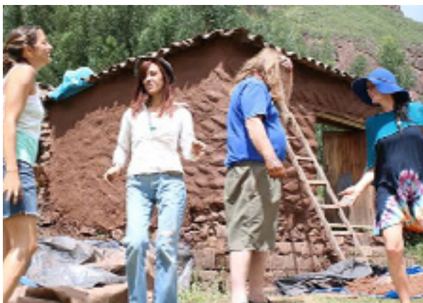
Imagen 1 Aplicación de aplanado en muro de arcilla, Bolivia (Moretti, 2015).
