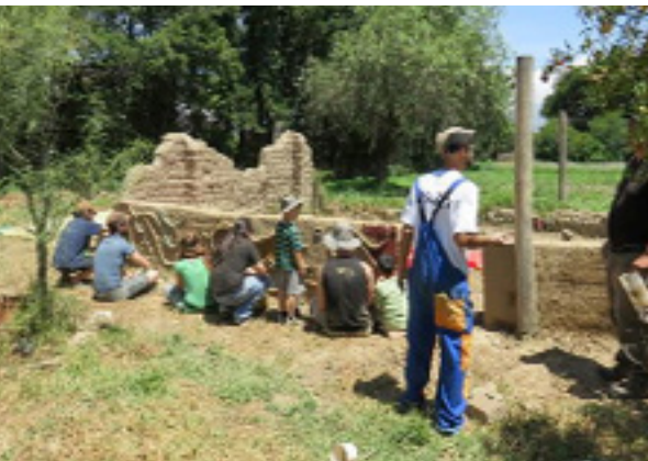
Imagen 3 Aplicación de aplanado en muros con base de arcilla, en Perú (Moretti, 2015).
