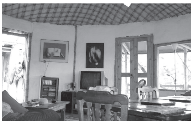
Figura 6. Colocación de costal de fique y malla de gallinero para reducir la fisuración del mortero de barro, vista exterior e interior. Fuente: propia
