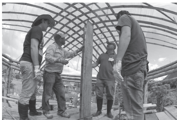
Figura 3. Elaboración de la trama de “latas” de guadua en domocaña, construidas prefabricadas desde abajo para montarlas a las estructuras o en el lugar desde el techo. Fuente: propia
