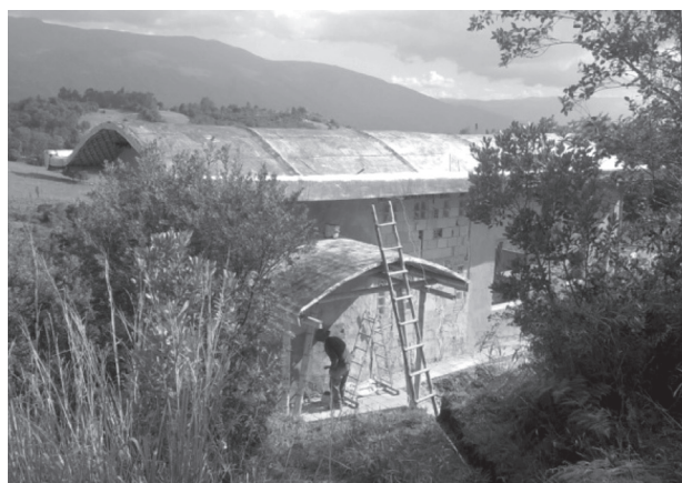
Figura 8. Impermeabilización de cubiertas con manto asfáltico y mortero. Fuente: propia
