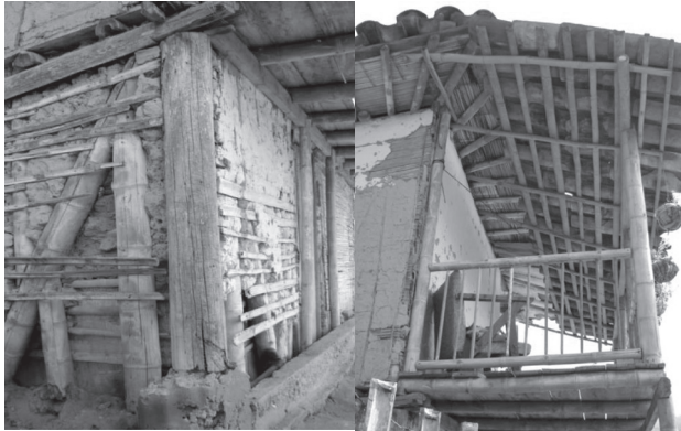
Figuras 16 y 17. Estructuras de guadua y arboloco, muros de bahareque y cagajón y esterilla de guadua. Fuente: elaboración propia
