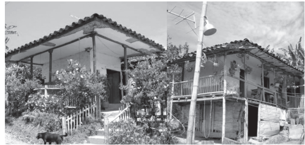
Figuras 18 y 19. Casas de La Pola construidas a finales del siglo XIX. Fuente: elaboración propia
