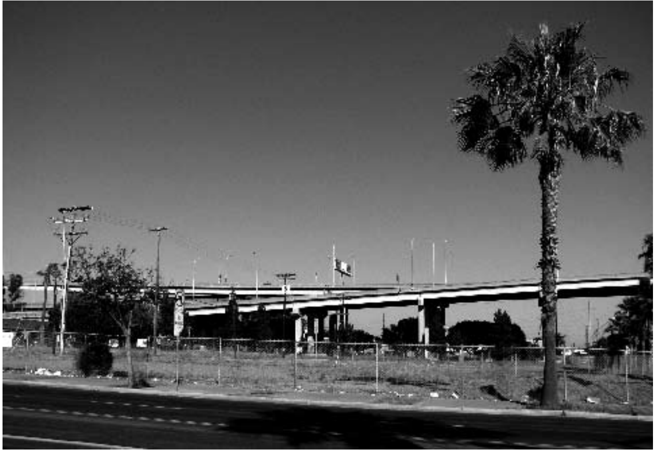
Arriba. Cruce puente Coronado y Autopista N5. Terreno baldío proyecto el mercado ab.
