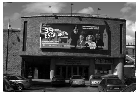
Arriba. Teatro La Castellana, conserva fachada y envolvente originales, actualmente es sede del Teatro Nacional.
