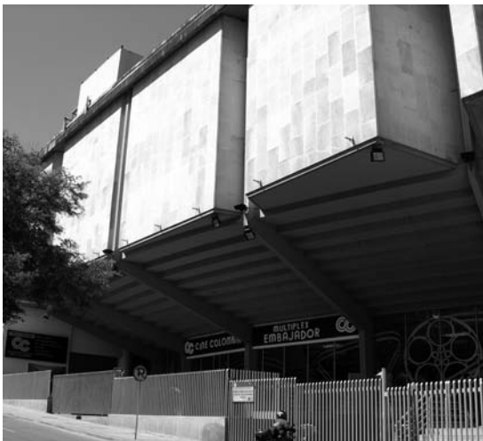
Arriba. Teatro Embajador, conserva fachada y envoltorio originales, actualmente es Multiplex con seis salas de cine.
