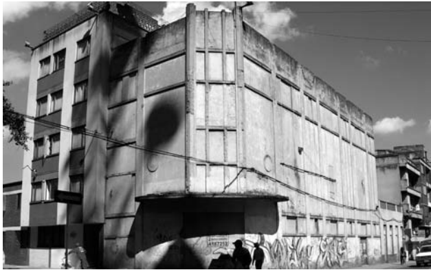
Arriba. Teatro Ariel, conserva fachada y envolvente originales, actualmente está abandonado.
