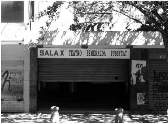
Arriba. Teatro Esmeralda, conserva fachada y envolvente originales, y como en la década de 1970, es sala x.
