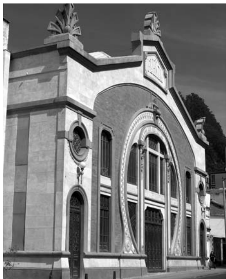
Arriba. Teatro Faenza, conserva fachada y envolvente originales, fue restaurado recientemente por la Universidad Central.
