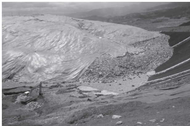
Imagen 1. Celda a cielo abierto del relleno sanitario Doña Juana, donde se observan las chimeneas que recogen el metano (CH 4 ), producto de la descomposición de los residuos.
