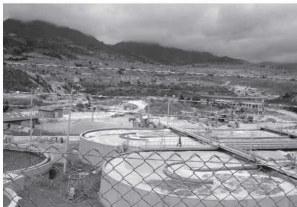
Imagen 2. Planta de tratamiento de lixiviados transportados por tuberías desde las celdas del relleno de Doña Juana, para luego ser vertidos al río Tunjuelo.
