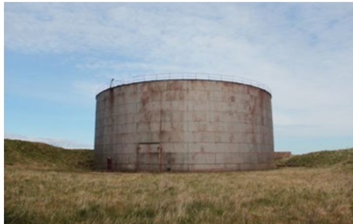
Vista exterior del tanque de almacenamiento de Lyness. Fotografía. Cortesía del autor (Klenner, 2019).
