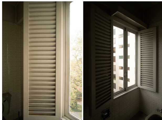
Figura 8. Las persianas metálicas. Fuente: elaboración propia.
